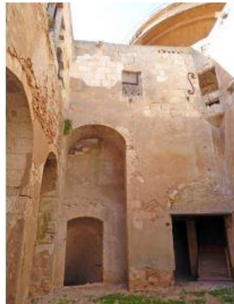
Fig. 8. Vista del patio del fuerte en un lado menor. A la derecha la entrada a la torre sur.
