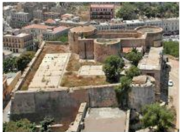
Fig. 16. Vista aérea del frente oeste y el baluarte nuevo con su explanada que ya abarcaba al antiguo revellín.
