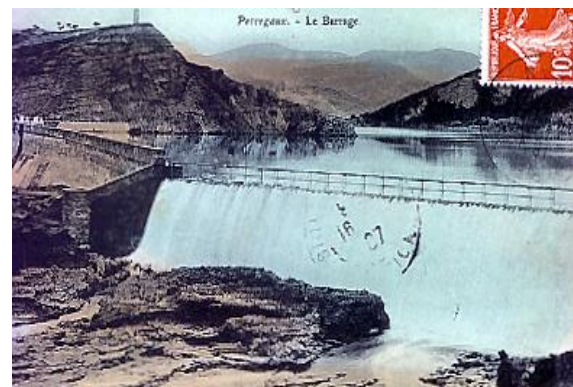
Le barrage de 1907
