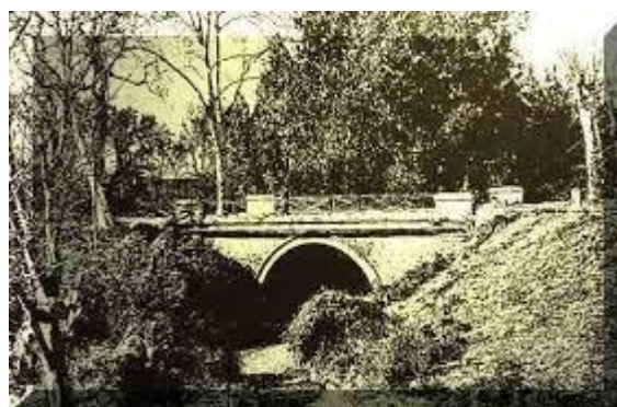
Le pont MALGLAIVE sur l'oued Meurad.
