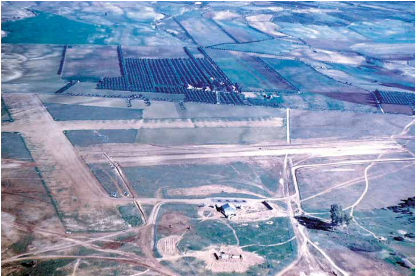
▼ L'aérodrome de Saïda en travaux
