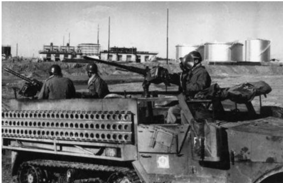
Station de pompage du pétrole à M'SILA et sa protection
