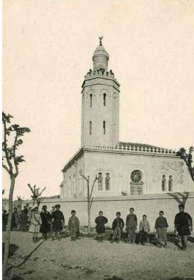
7. CLAIRFONTAINE - La Mosquée
