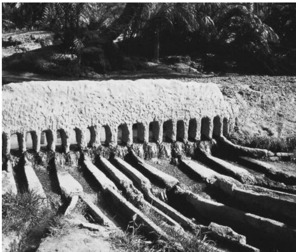
[Un peigne-partiteur au débouché d'une séguia de foggara dans la palmeraie de Timimoun (photo J. Bisson)]
