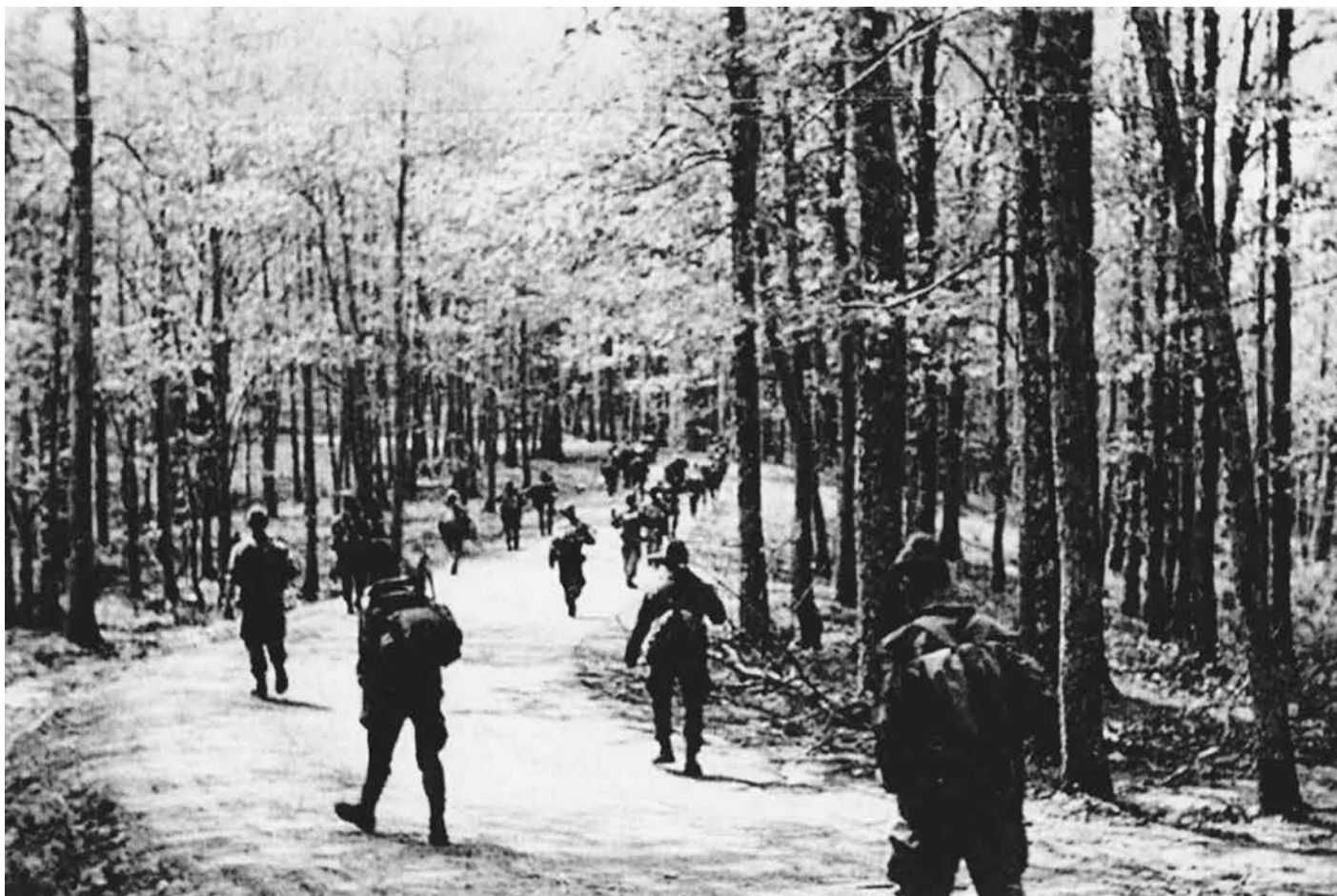
▼ Mise en place au col de Selma
