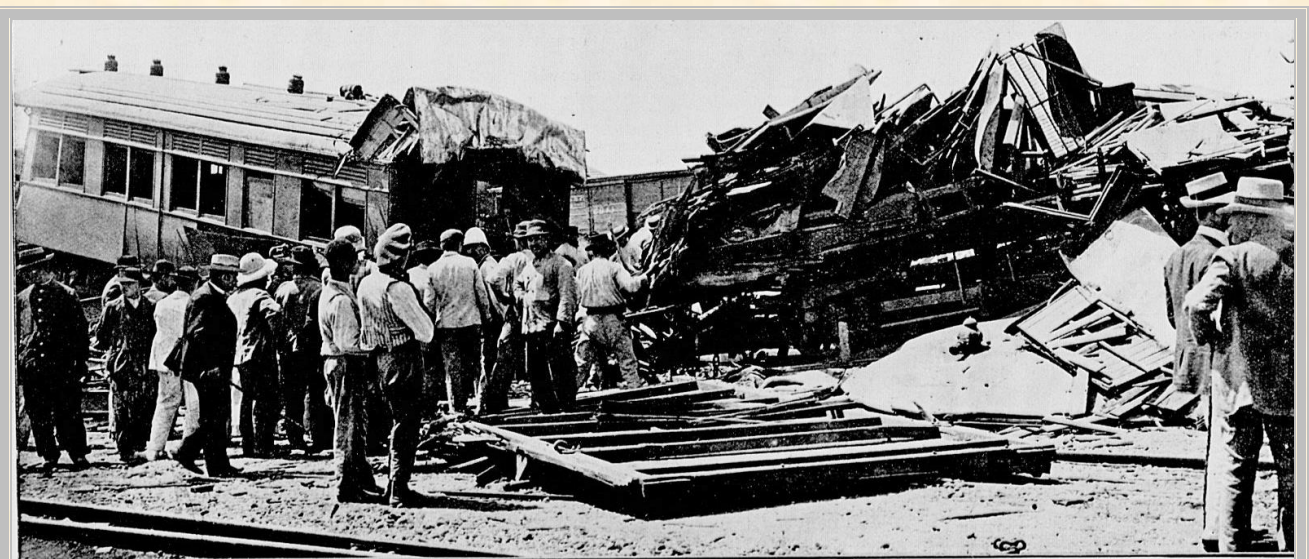
LES TRAVAUX DE DÉBLAIEMENT
