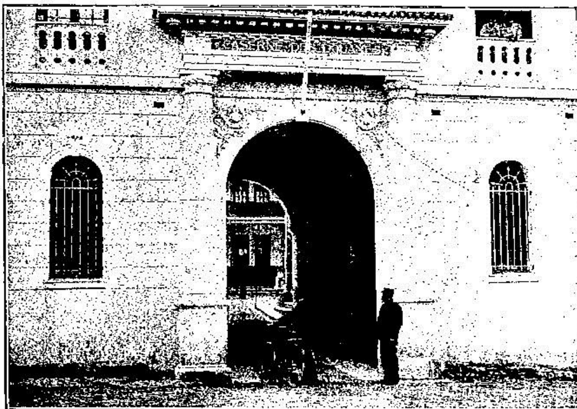
LA PORTE D'ENTRÉE DE LA CASERNE DES DOUANES
