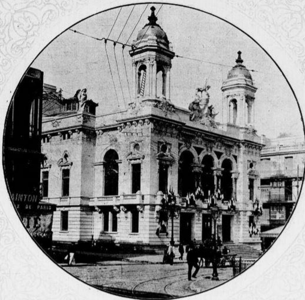
LE NOUVEAU THÉÂTRE D'ORAN, DONT LA PREMIÈRE PIERRE FUT POSÉE AU MOIS DE SEPTEMBRE 1905, EN PRÉSENCE DE MM. JONNART, GOUVERNEUR GÉNÉRAL ; ÉTIENNE, MINISTRE DE LA GUERRE, ET GAUTIER, MINISTRE DES TRAVAUX PUBLICS, ET DONT L'INAUGURATION VIENT D'AVOIR LIEU EN GRANDE SOLENNITÉ. Photo A. Lock, Oran.
