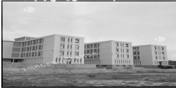
Les bâtiments de l'école militaire annexe des transmissions d'Afrique du nord à Beni-Messous.
