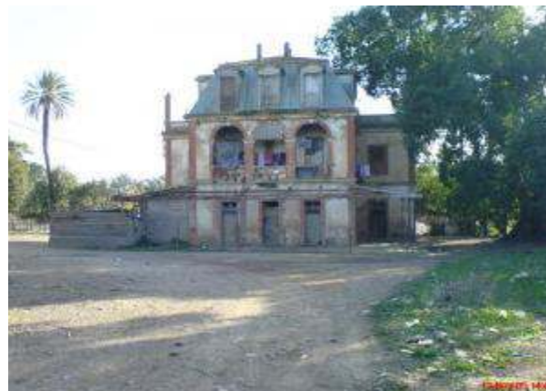
Une maison de notre époque (peu entretenue).
