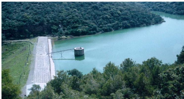
Le premier projet de barrage date de 1851 et fut présenté par le Capitaine de Génie MALGLAIVE; l'ouvrage avait 24 mètres de hauteur et était muni d'un déversoir en puits. Le projet définitif, arrêté en 1852 par le Colonel BIZOT, fut exécuté entre 1852 et 1859, sans aucune précaution ni prudence, et en particulier sans respecter les données du projet du Colonel BIZOT.
