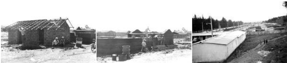
Septembre 1961, construction en dur pour le regroupement des populations.
