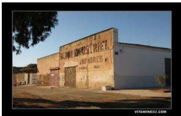
Vestiges de la compagnie du béton industriel à RENAN
