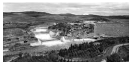
Barrage du GHRIB
