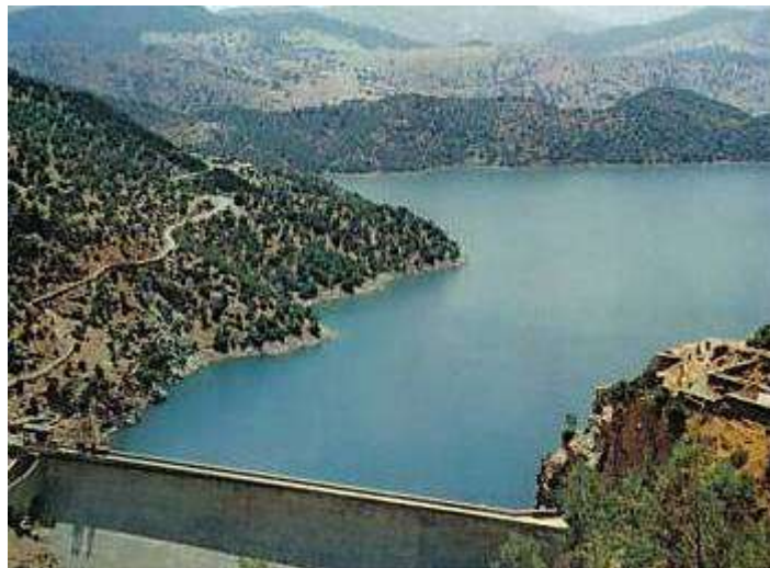
Barrage de l'Oued FODDA mis en service en 1932
