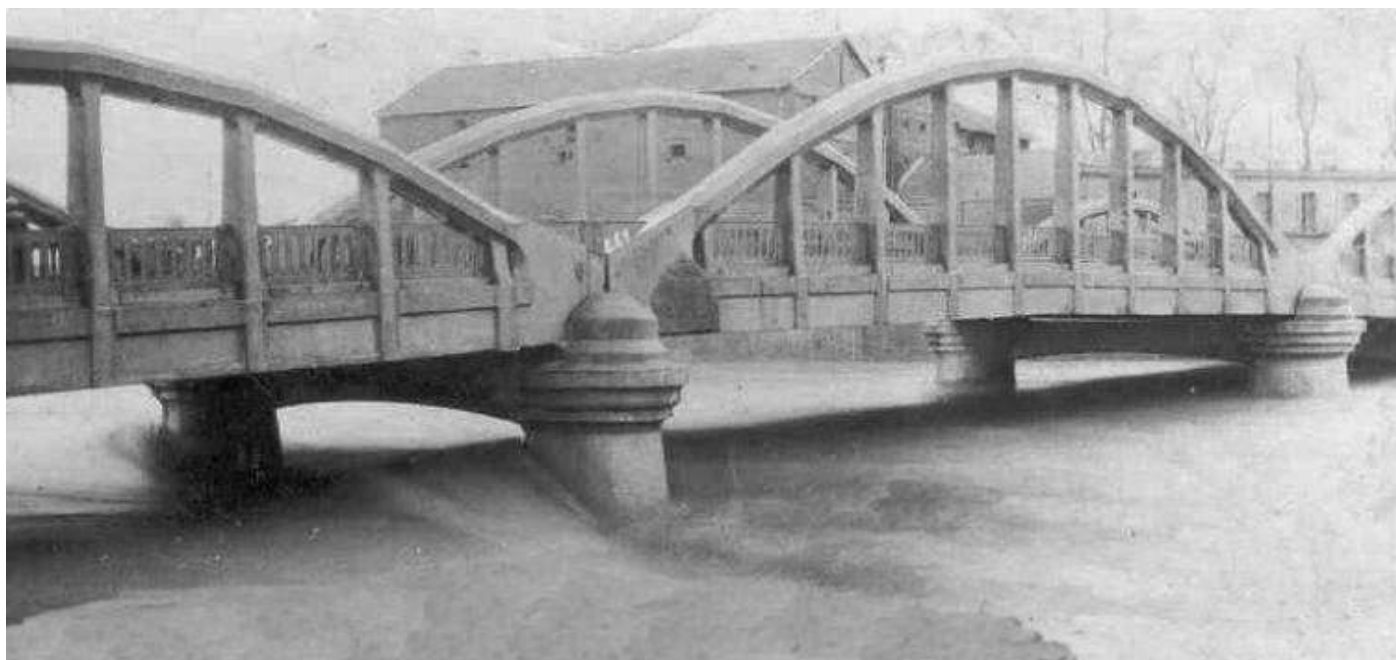
Le nouveau pont de MAISON CARREE
