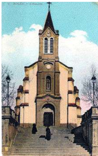
KOLEA a été érigée en paroisse dès 1848. L'église
