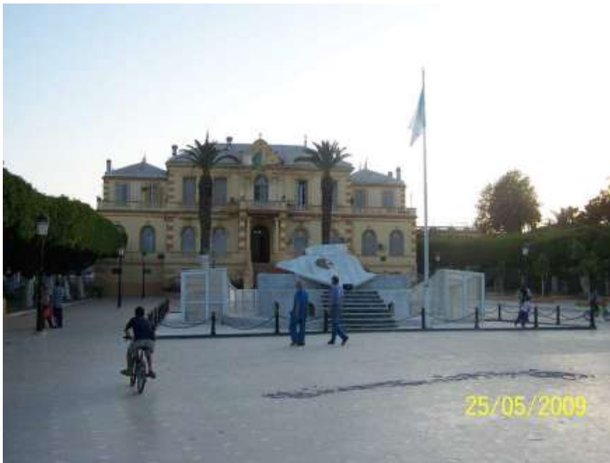
On constate que le Kiosque a été rasé.
