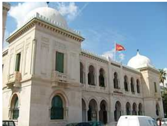
Façade du Collège SADIKI :
