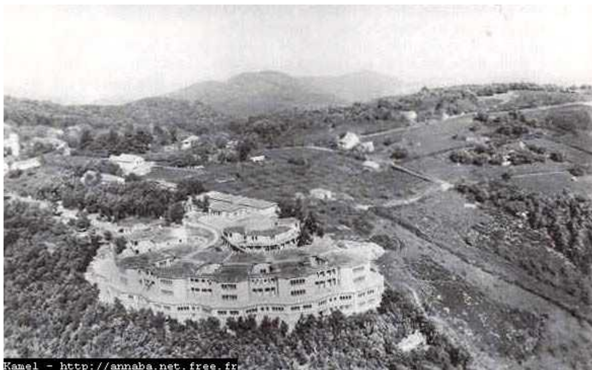
Le Préventorium construit en 1955.
