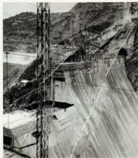
Mai 1932 — Bétonnage de la partie supérieure des blocs rive gauche.
