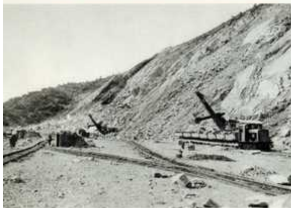
La carrière — Exploitation par sautages en grandes masses; chargement par pelles électriques 1 300 volts à godet de 1,5 m 3
