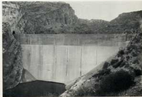
Juillet 1932 — Vue du parement amont terminé. Début du remplissage de la retenue. La comparaison avec la situation en avril montre l'importance du bétonnage réalisé en 3 mois.
