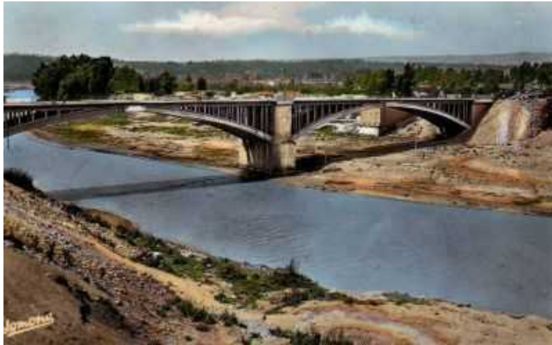
ORLEANSVILLE - Pont du CHELIFF
