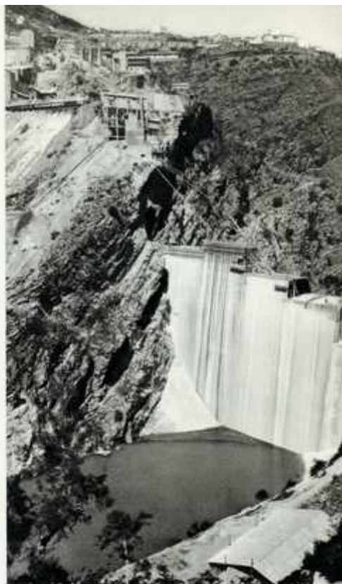
Avril 1931 — Vue amont du barrage en construction et des installations.
