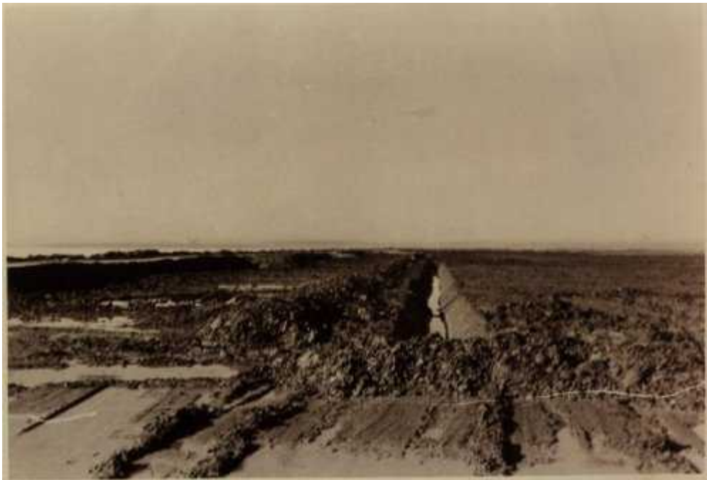
Travaux d'assainissement de la MITIDJA
