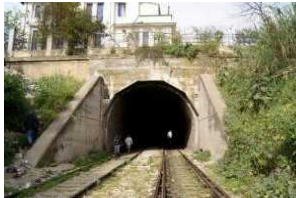
Tunnel ferroviaire de MÈNERVILLE
