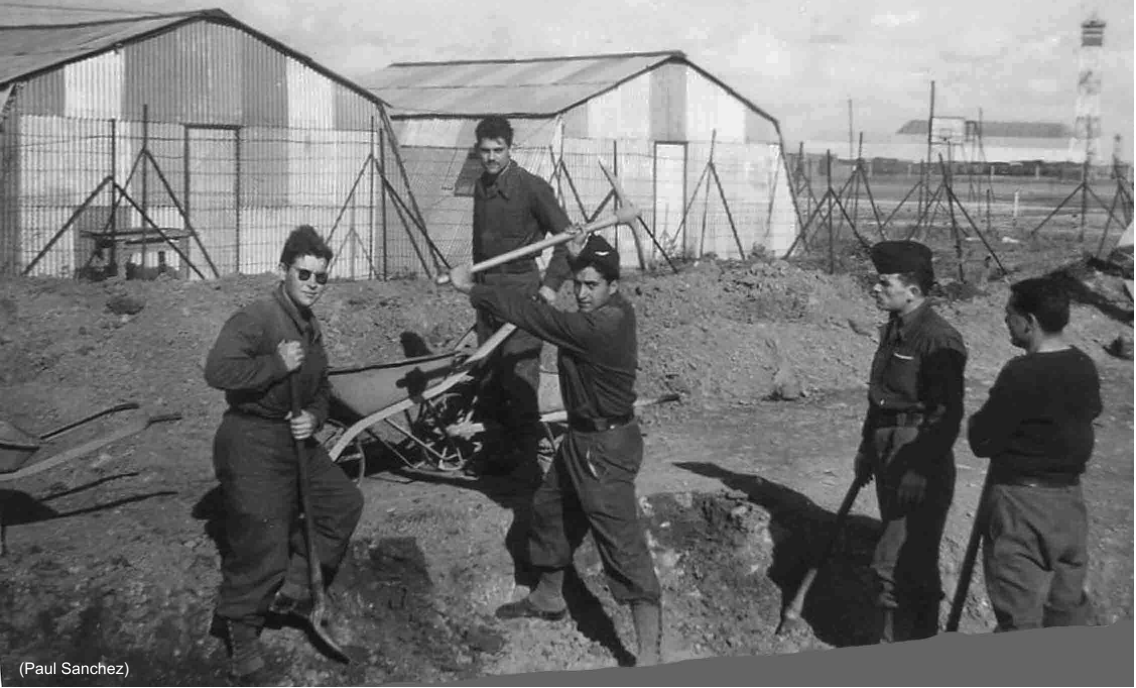
Le creusement de la piscine – Décembre 1960
