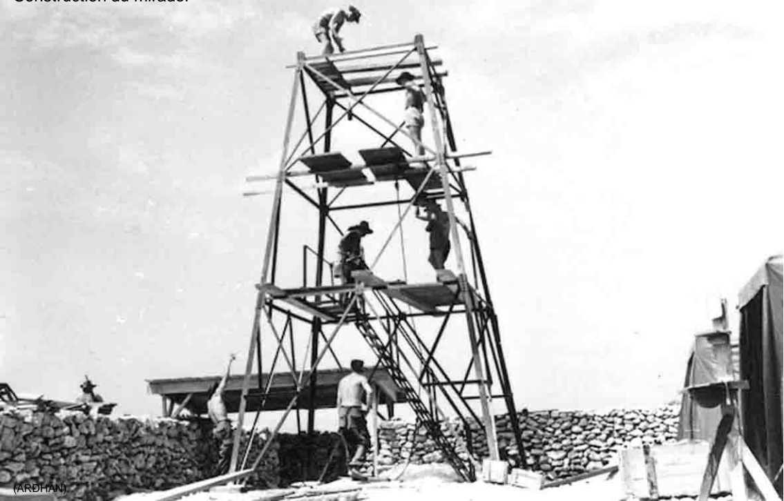
Construction du mirador
