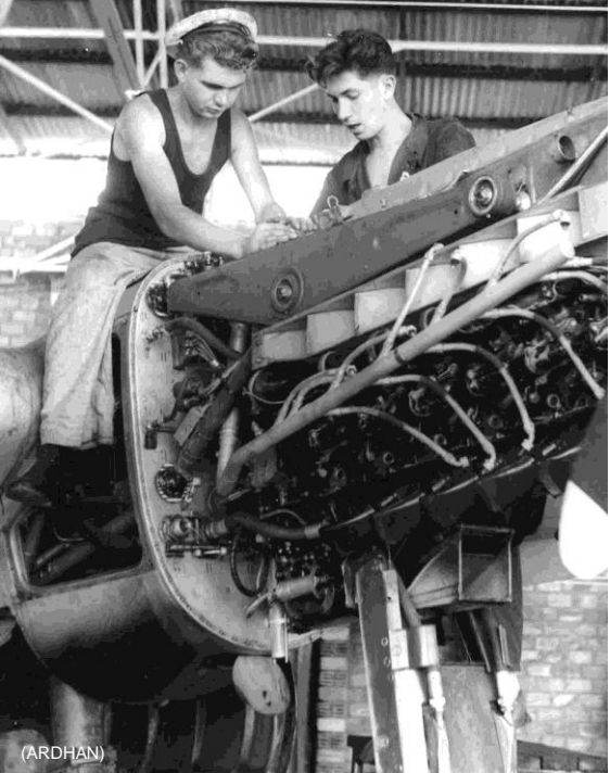
4S - Entretien du moteur Renault (SNECMA) 6Q 10 en 1952/1955
