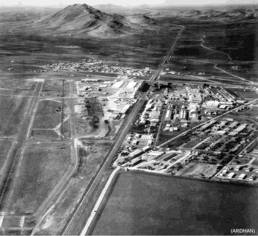
Axe de la piste 26 (La voie ferrée traverse la base)
