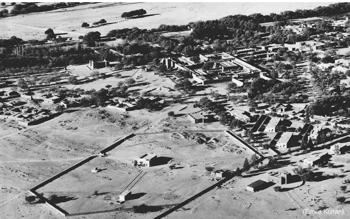
Tamanrasset-Ville – 1959 – Au premier plan, l'aérogare dans l'enceinte
