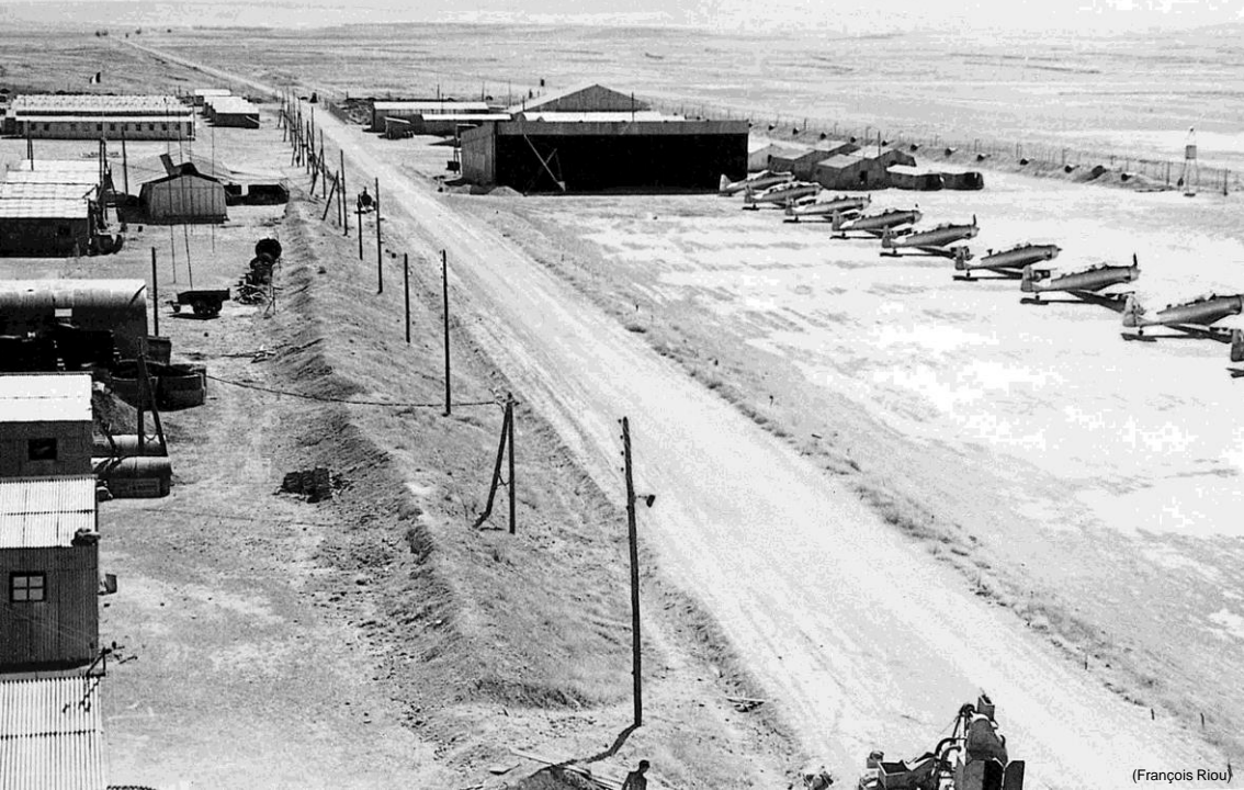
Djelfa – 1956 – Emplacement du hangar de l'ALAT, pas encore construit, à droite près de la piste
