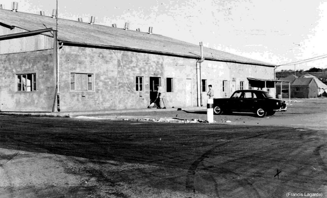
La salle OPS au début de l'installation
