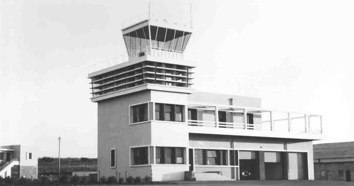
La tour de contrôle et le bâtiment technique vus depuis la piste
