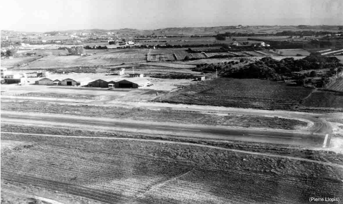
Le seuil de piste 08 et le hangar de l'Aéro-club de l'AIA au début de la rangée
