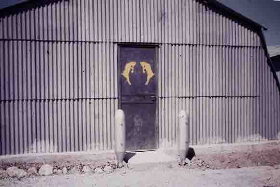
Les installations sommaires de l'EALA 3/72 en 1958, avant que la construction de la Base soit terminée
