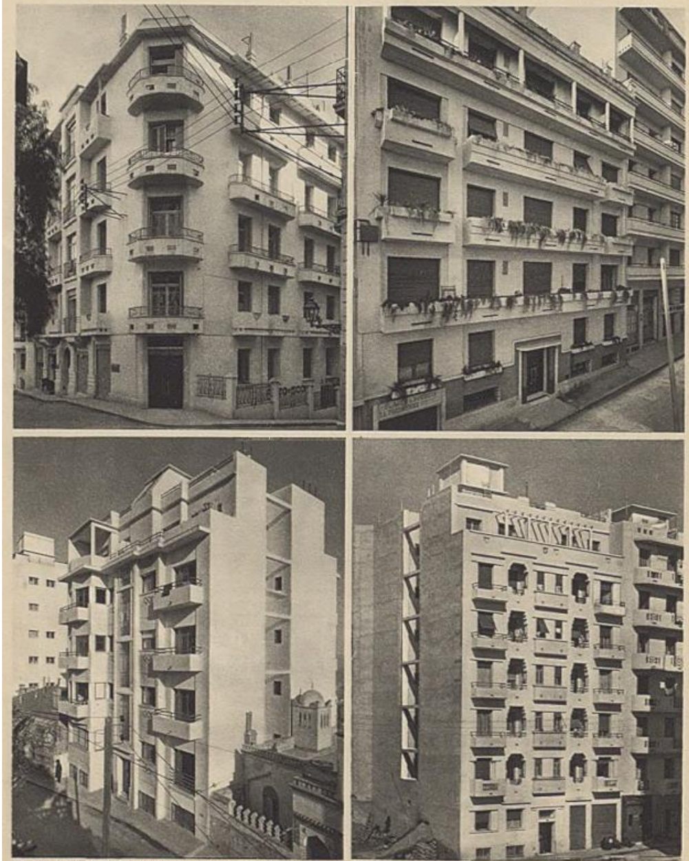
En haut et à gauche : M. LOMBARDI, Architecte ; Michel PANDOLFO, Constructeur Métallique. En haut et à droite : M. ROSAZZA, Architecte ; Ateliers DURAFOUR, Constructeurs Métalliques. En bas et à gauche : M. VOIRON, Architecte ; Ateliers DURAFOUR, Constructeurs Métalliques. En bas et à droite : M. ETIENNE, Architecte ; FAINDAVOINE Frères, Constructeurs Métalliques. Photos EICHACKER.
