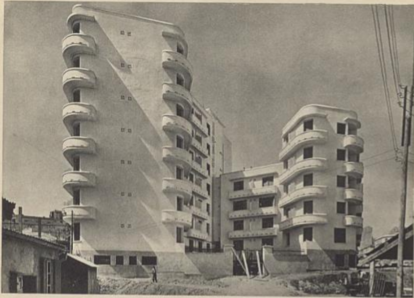
Immeuble de logement, Groupe des Anciennes Messagères | M. FÉLIX, Architecte | OMNIBUS D'ENTREPRISES, Constructeurs Métalliques. Photo EICHACKER.
