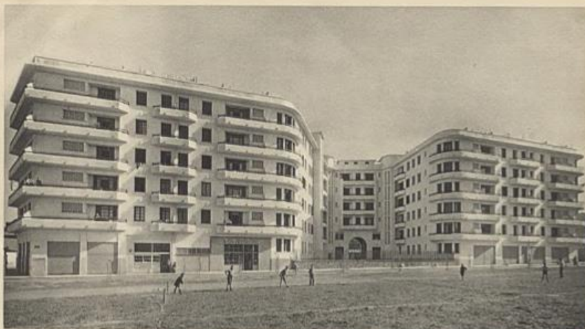
Immeuble de logement, Groupe VAUBAN ; M. PREULH, Architecte ; Société des Etablissements ROBERT & Co, Constructeurs Métalliques. Photo EICHACKER.
