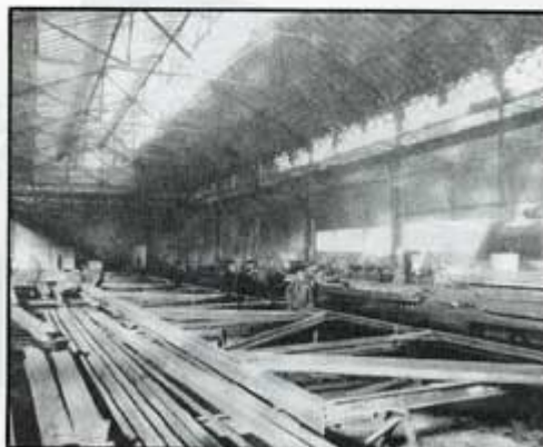
Hussein-Dey : Hall d'assemblage « Charpente »
